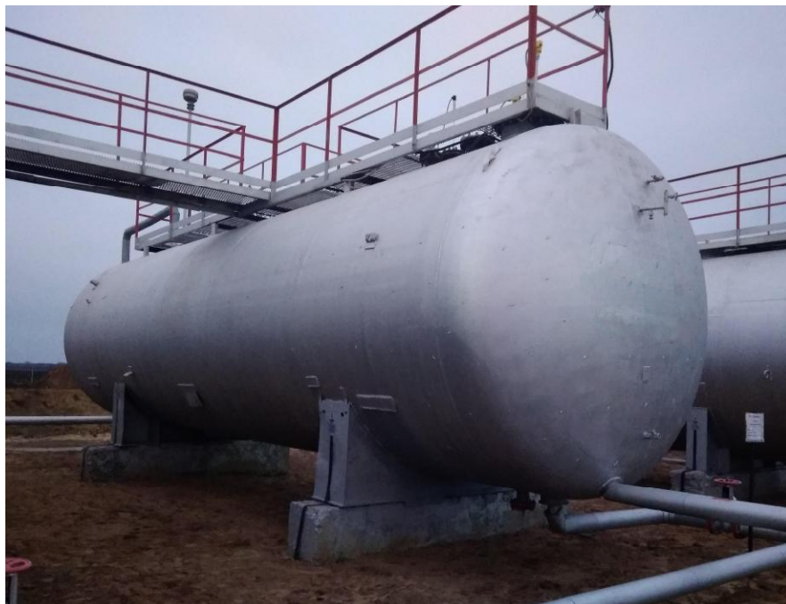
Рисунок 1 - Общий вид резервуаров РГС-76, РГС-77
