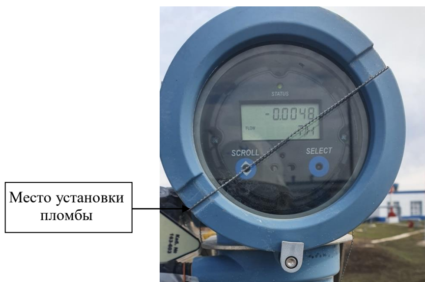
Рисунок – 2 Схема пломбировки от несанкционированного доступа преобразователя серии 2700.
