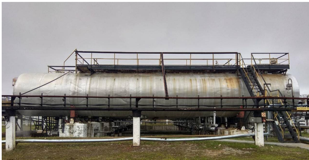
Рисунок 1 - Общий вид резервуара стального горизонтального цилиндрического РГС-200
