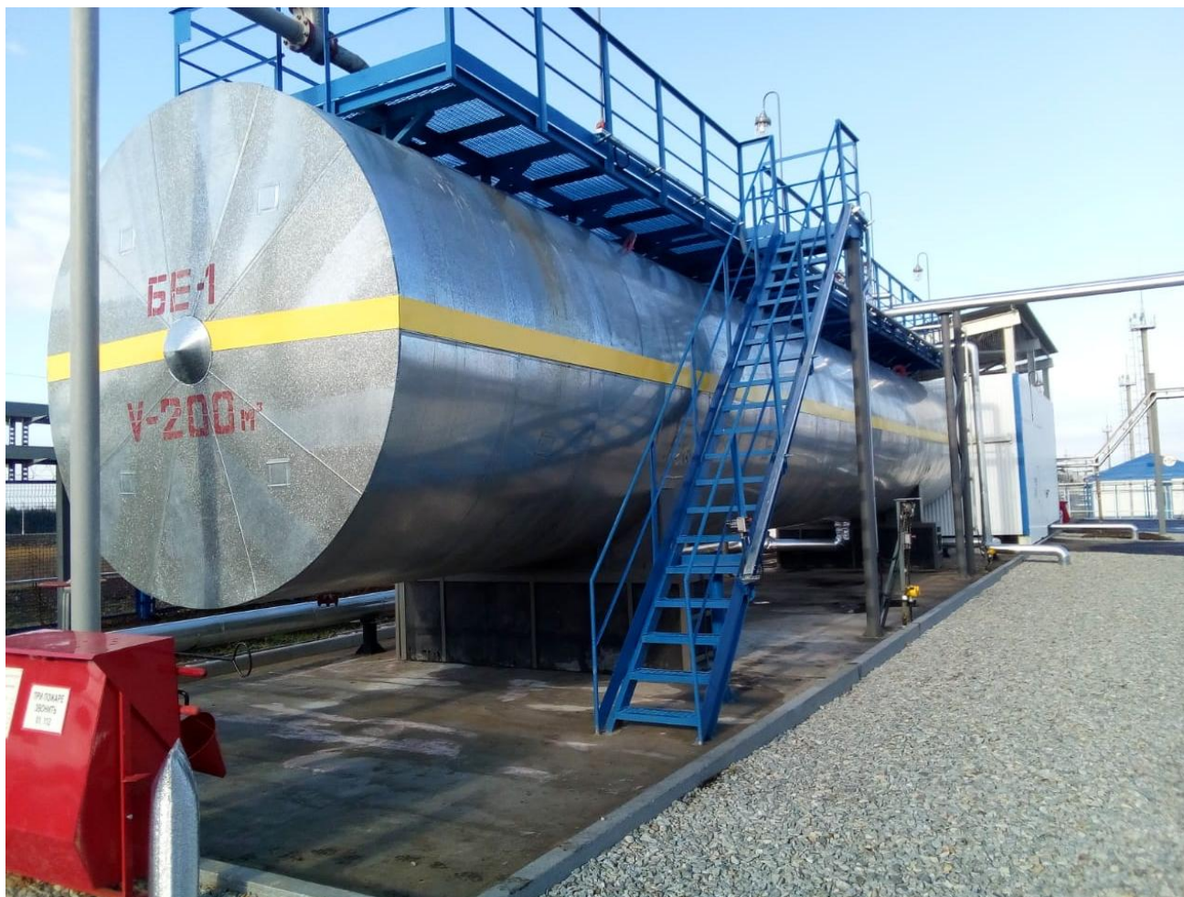
Рисунок 1 - Общий вид резервуара РГС-200
