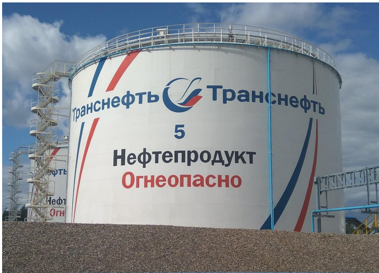
Рисунок 1 - Общий вид резервуара вертикального стального цилиндрического РВС-10000
