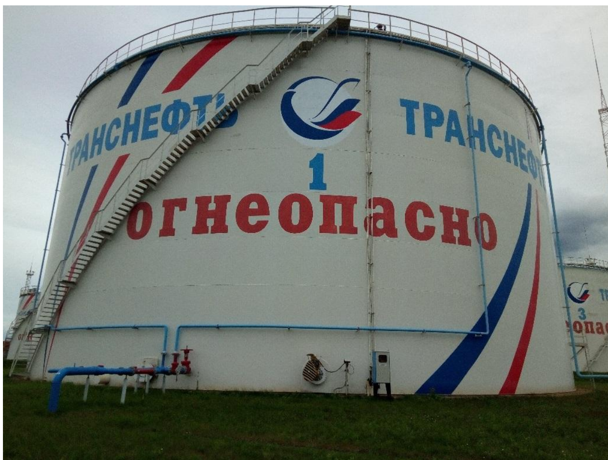
Рисунок 3 - Общий вид резервуара вертикального стального цилиндрического РВСП-20000
