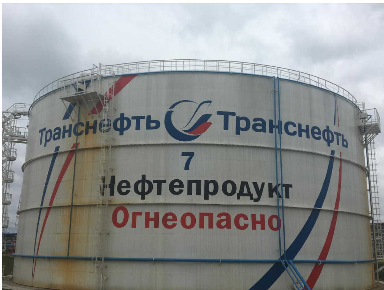
Рисунок 2 - Общий вид резервуара вертикального стального цилиндрического РВС-20000
