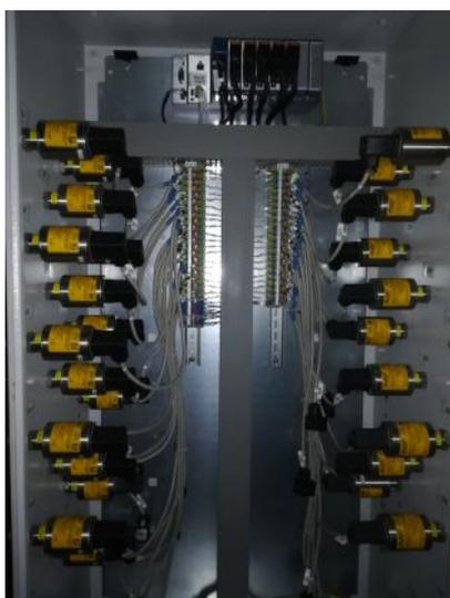
Рисунок 3 - Шкаф датчиков давления
