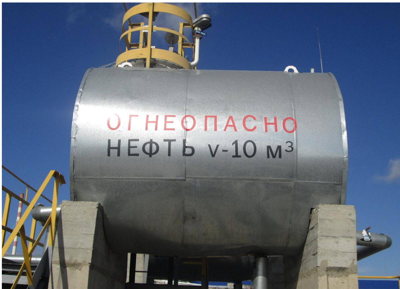
Рисунок 2 - Общий вид резервуара РГС-10
