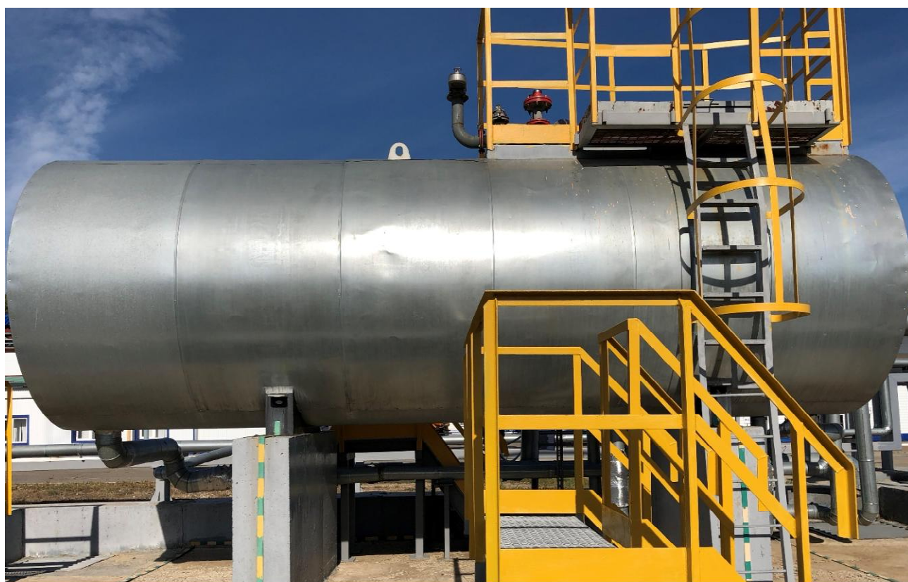
Рисунок 3 - Общий вид резервуара РГС-17
