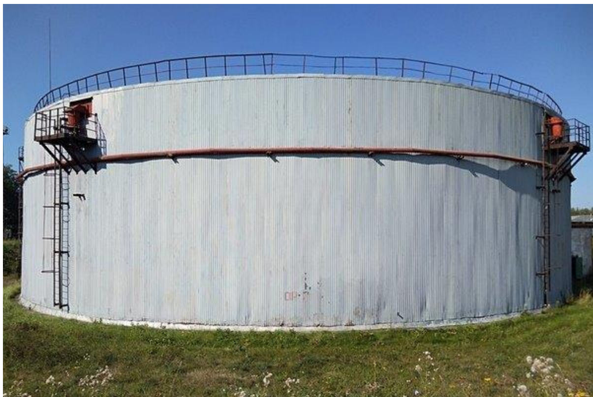
Рисунок 1 - Общий вид резервуара РВС-20000 № 2
