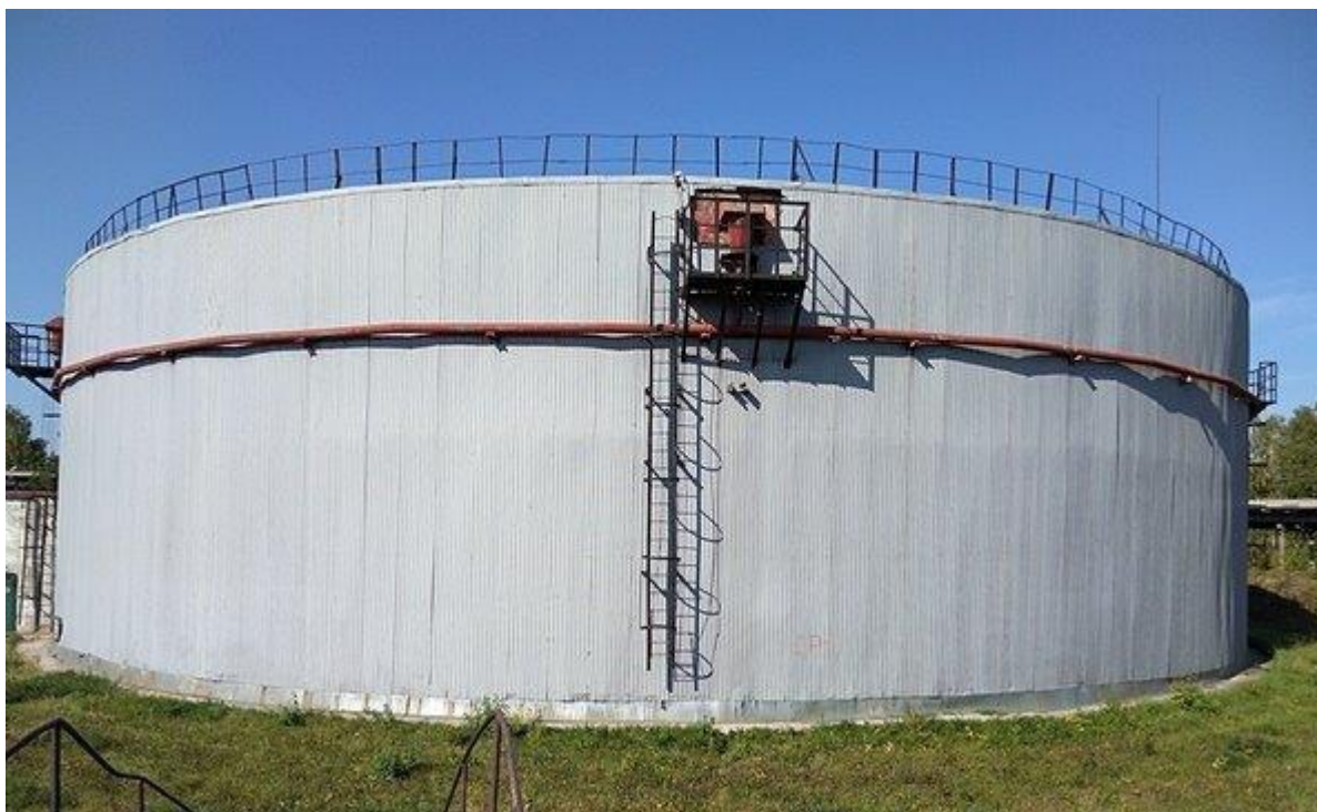
Рисунок 1 - Общий вид резервуара
