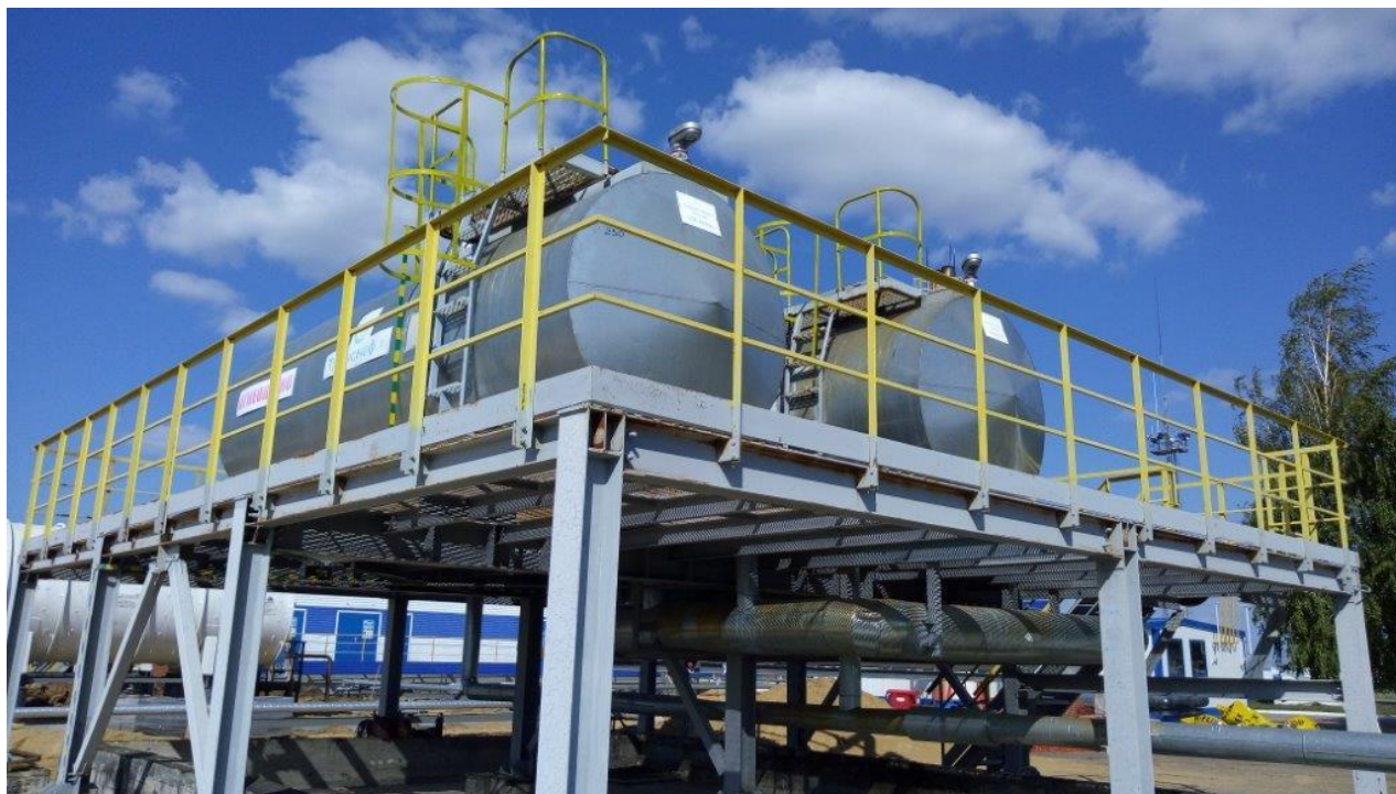
Рисунок 2 - Общий вид резервуаров РГС-17 №№ 8, 9
