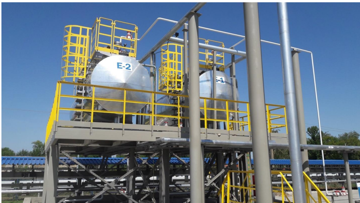
Рисунок 1 - Общий вид резервуаров РГС-17 №№ 1, 2
