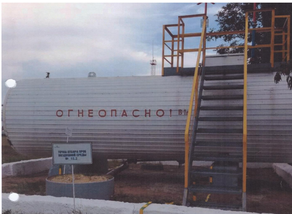
Рисунок 1 - Общий вид резервуара РГС-20 № 2
