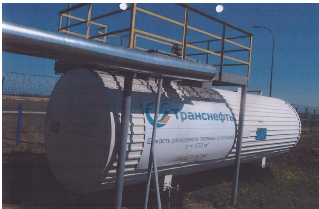
Рисунок 2 - Общий вид резервуара РГС-20 № 6504/16
