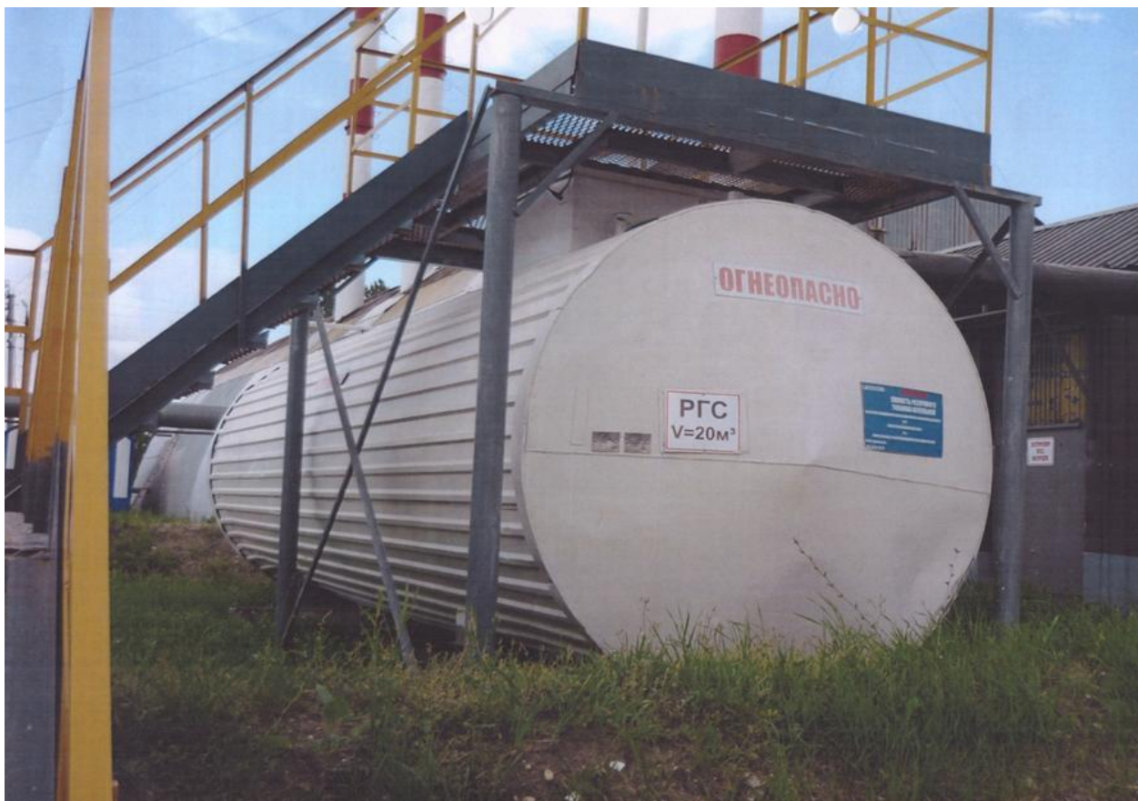
Рисунок 3 - Общий вид резервуара РГС-20 №6399 36/36
