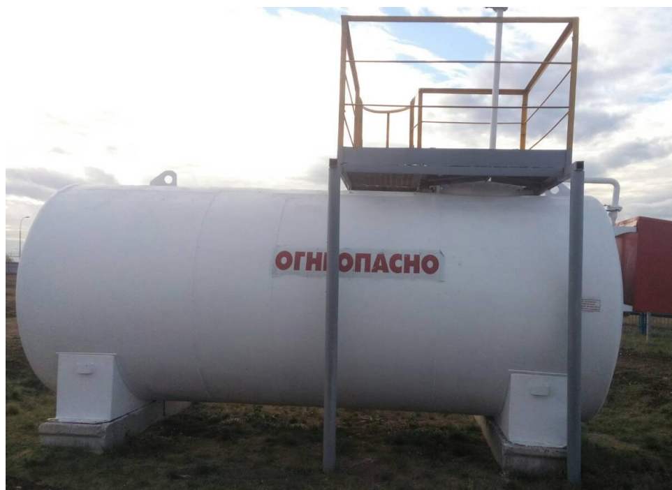
Рисунок 1 - Общий вид резервуара
