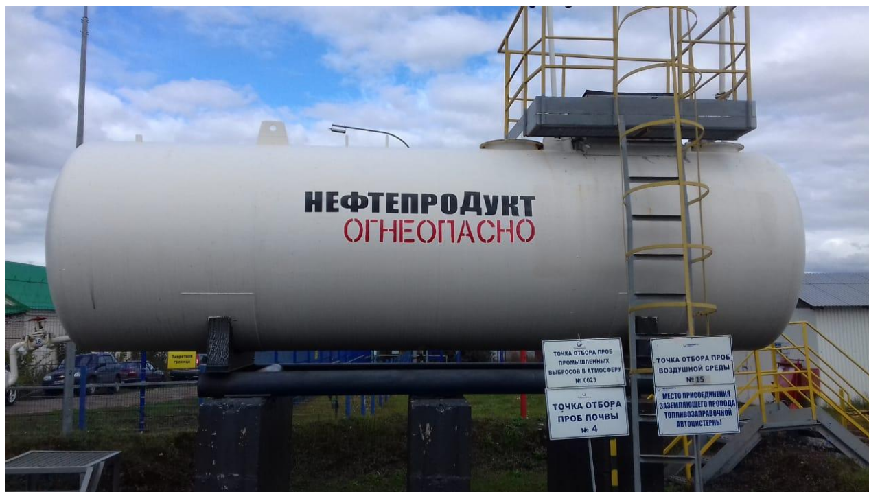
Рисунок 3 - Общий вид резервуара РГС-20 № 6505
