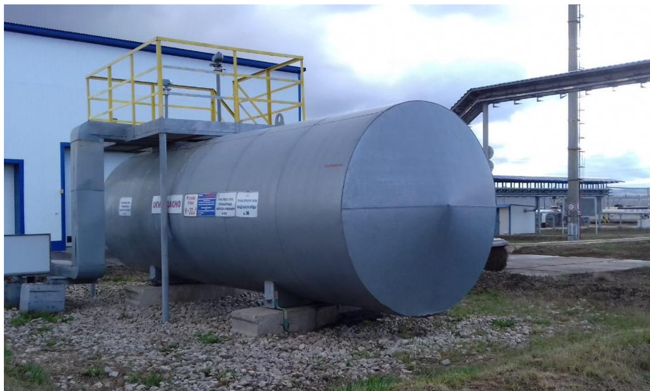
Рисунок 1 - Общий вид резервуара РГС-20 № 88
