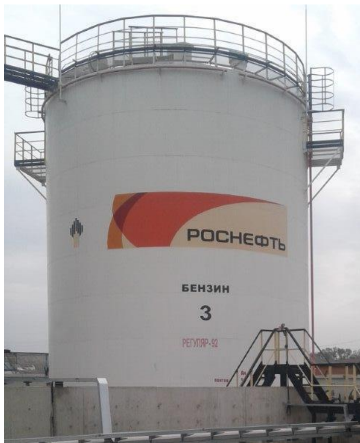
Рисунок 1 - Общий вид резервуара стального вертикального цилиндрического РВС-1000
