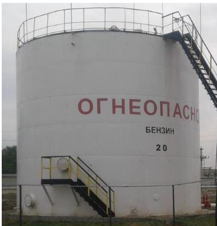
Рисунок 2 - Общий вид резервуара стального вертикального цилиндрического РВС-700
