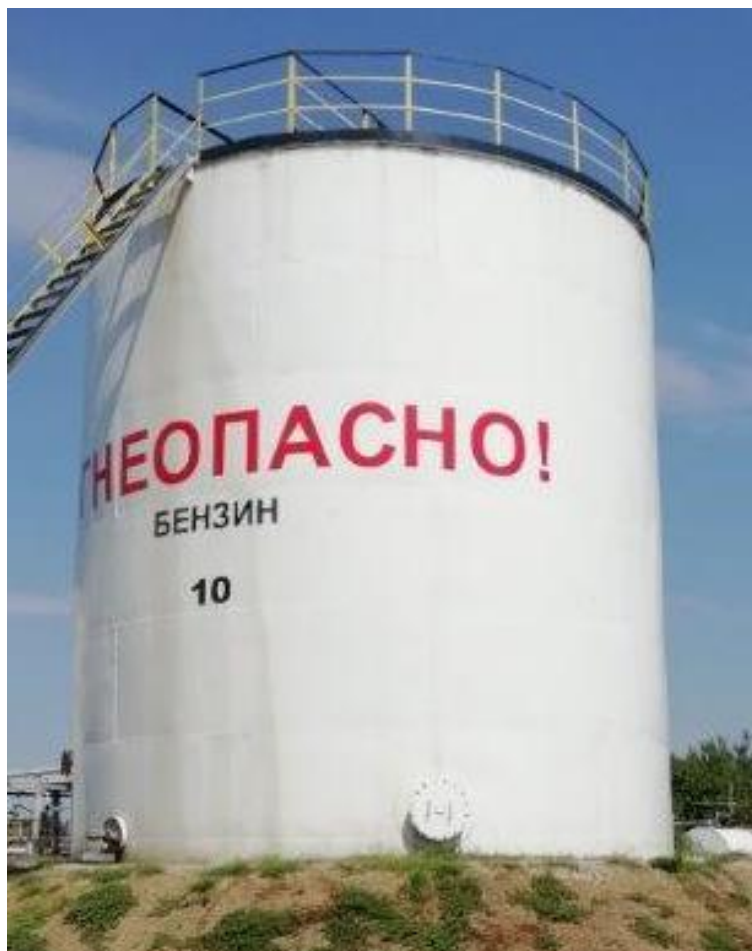
Рисунок 1 - Общий вид резервуара стального вертикального цилиндрического РВС-400
