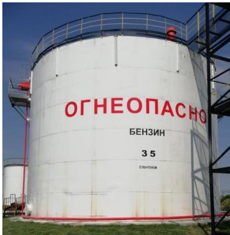
Рисунок 3 - Общий вид резервуара стального вертикального цилиндрического РВС-1000
