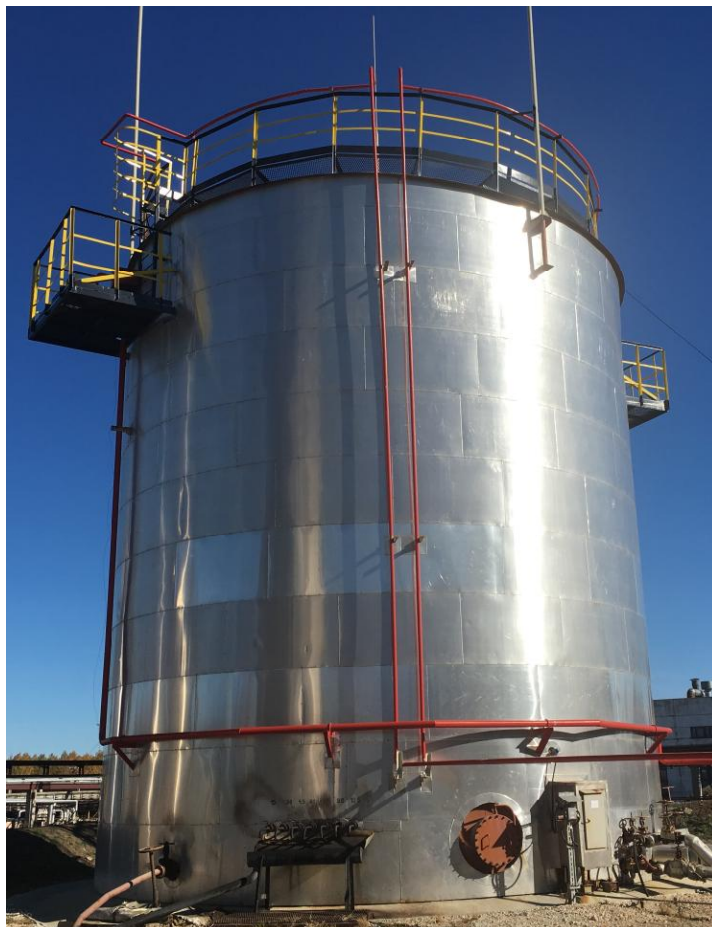
Рисунок 1 - Общий вид резервуара стального вертикального цилиндрического РВС-1000
