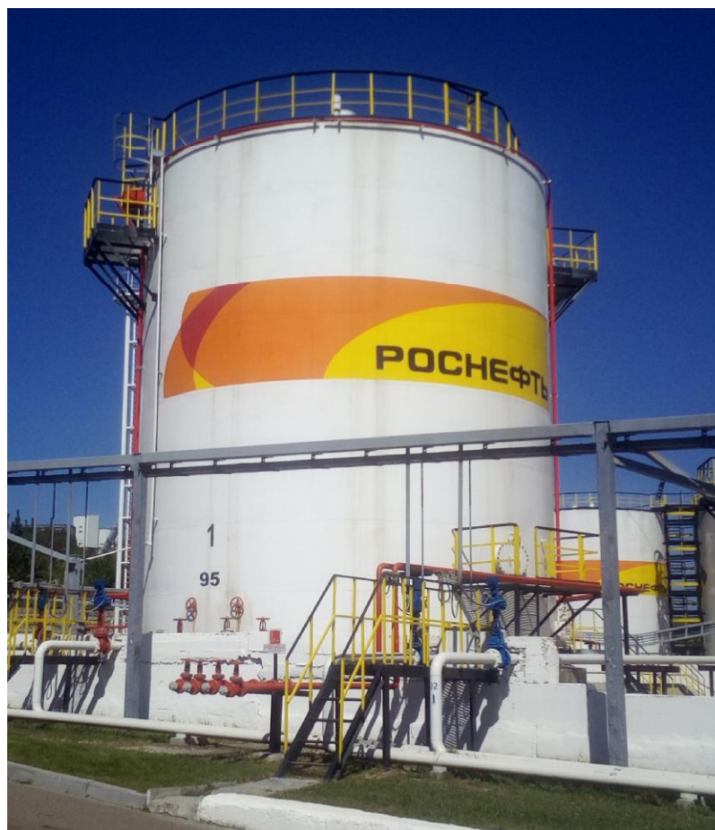
Рисунок 1 - Общий вид резервуара стального вертикального цилиндрического РВС-1000
