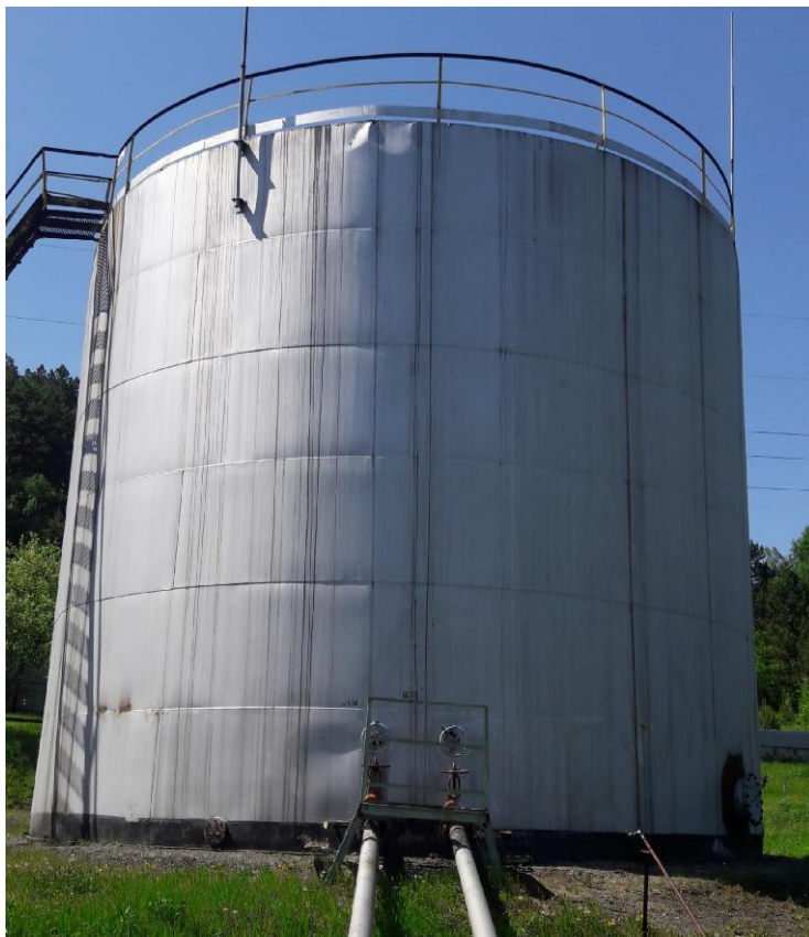
Рисунок 2 - Общий вид резервуара стального вертикального цилиндрического РВС-700
