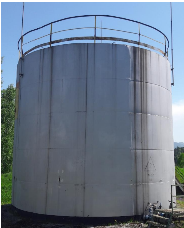
Рисунок 1 - Общий вид резервуара стального вертикального цилиндрического РВС-400
