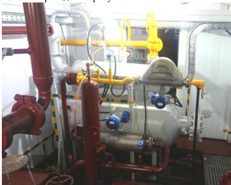
Рисунок 1 – Установка измерительная «МЕРА-ММ.103». Общий вид.
