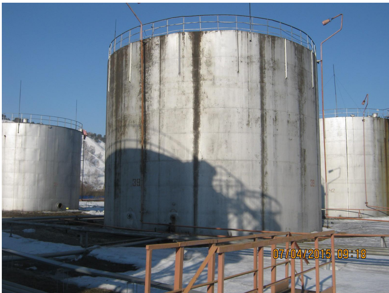
Рисунок 1 - Общий вид резервуара вертикального стального цилиндрического РВС-2000
