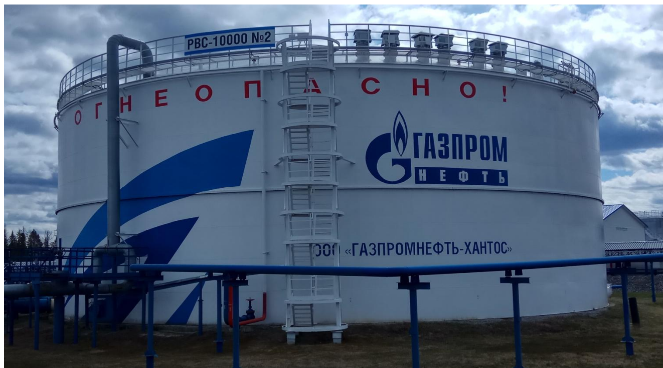
Рисунок 1 - Общий вид резервуара РВС-10000
