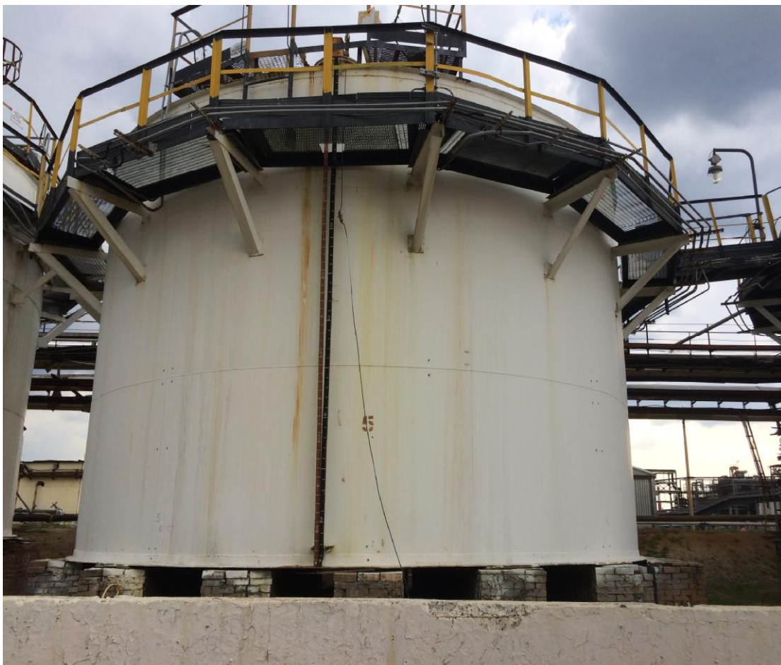
Рисунок 1 - Общий вид резервуара стального вертикального цилиндрического РВС-300
