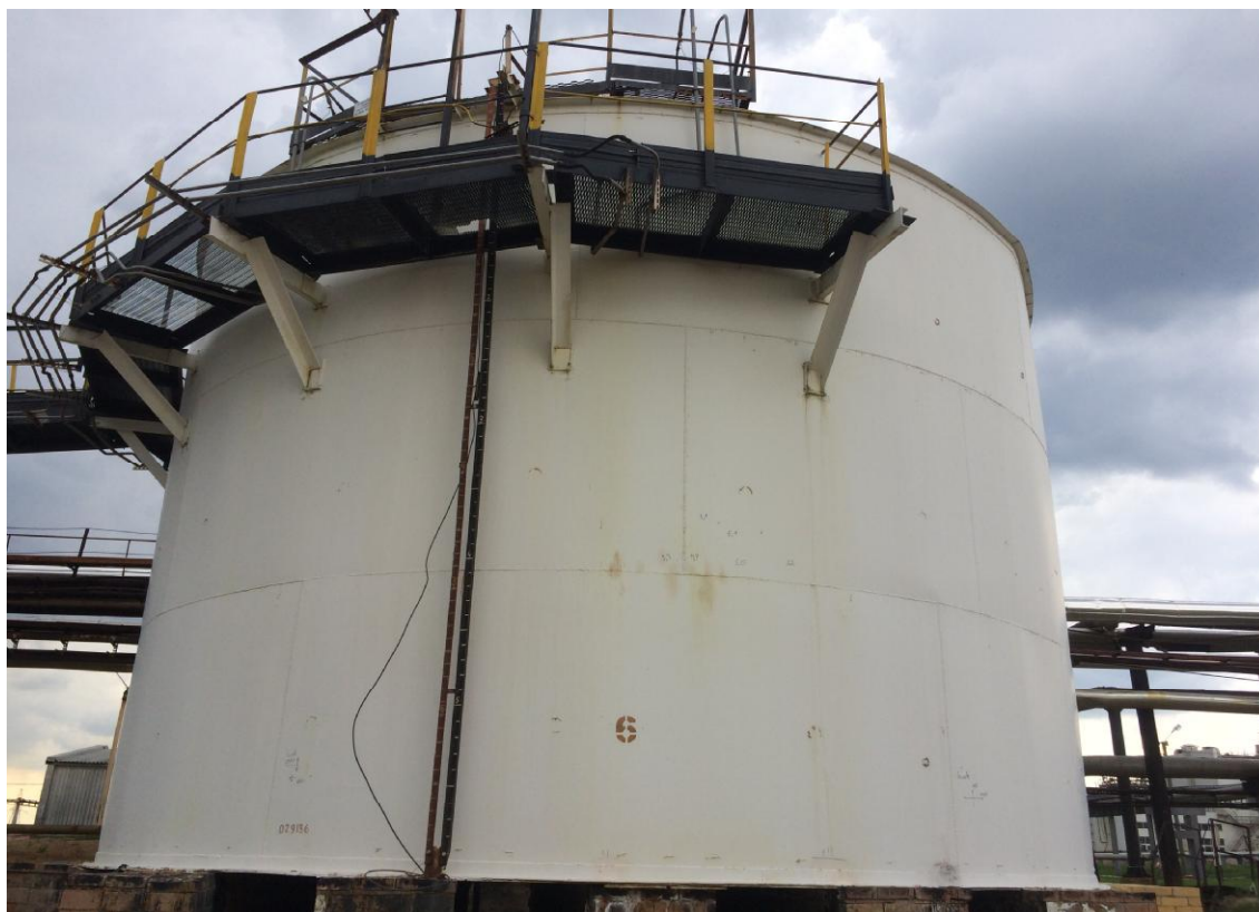
Рисунок 1 - Общий вид резервуара стального вертикального цилиндрического РВС-400
