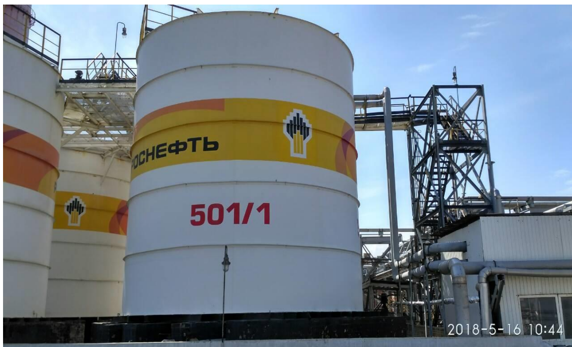
Рисунок 1 - Общий вид резервуара стального вертикального цилиндрического РВС-500
