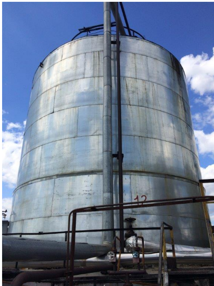
Рисунок 1 - Общий вид резервуара стального вертикального цилиндрического РВС-400
