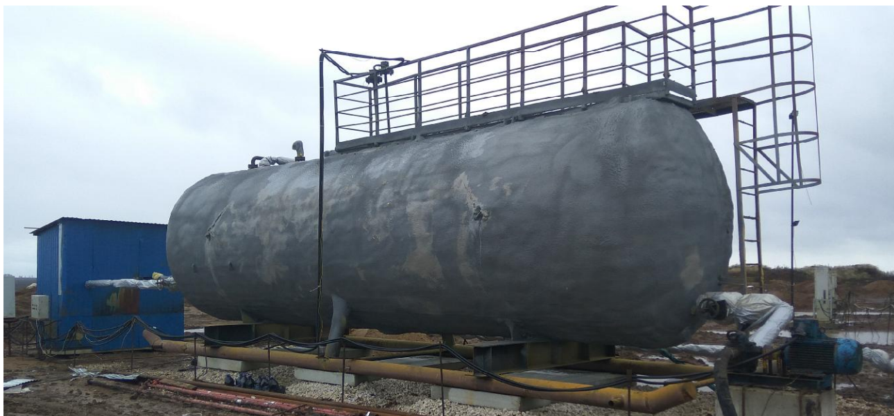
Рисунок 1 - Общий вид резервуара РГС-75
