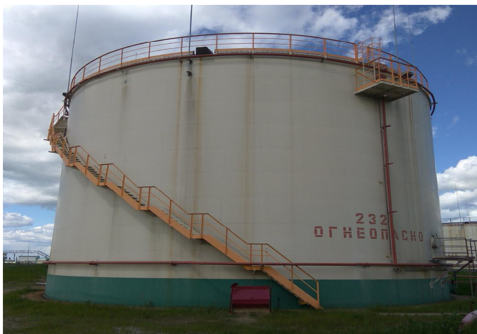
Рисунок 1 - Общий вид резервуара РВСП-10000
