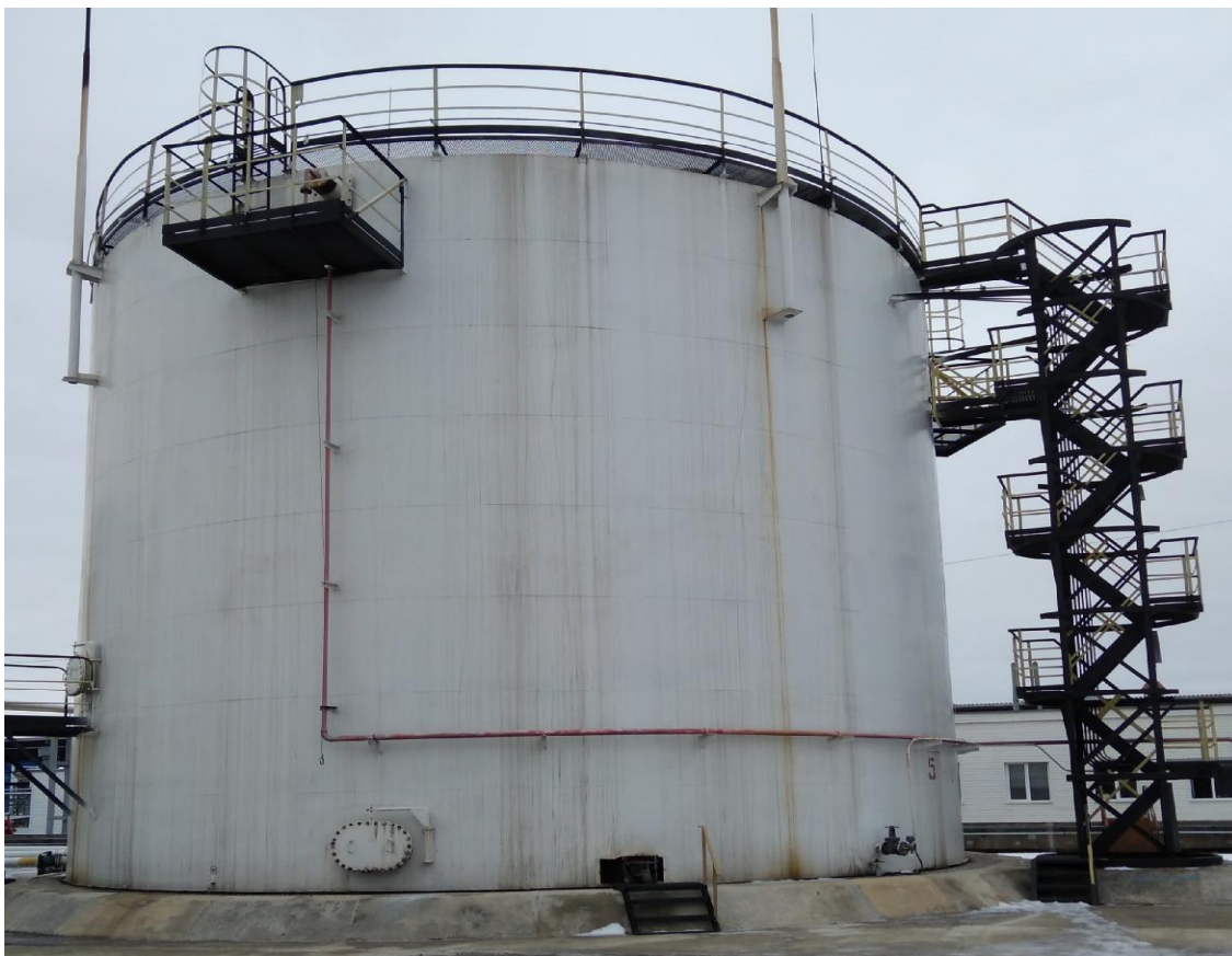
Рисунок 1 - Общий вид резервуара стального вертикального цилиндрического РВСП-2000
