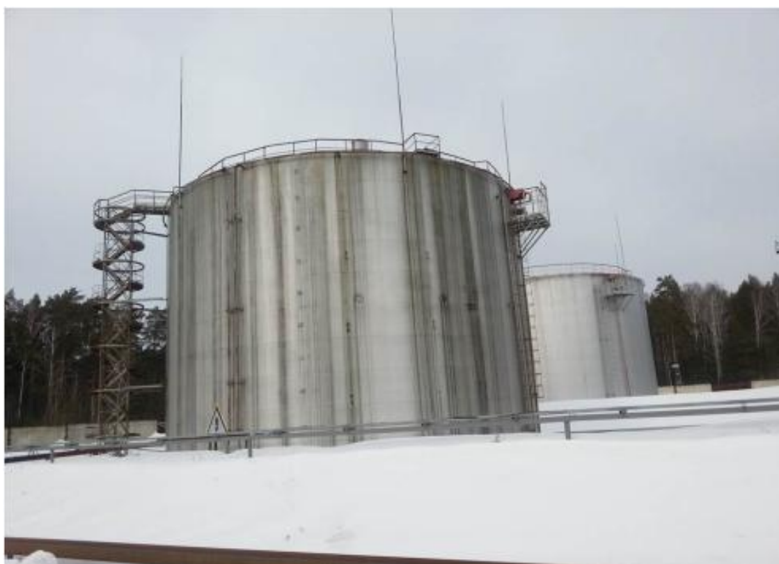
Рисунок 3 – Общий вид резервуара вертикального стального цилиндрического РВСП-5000
