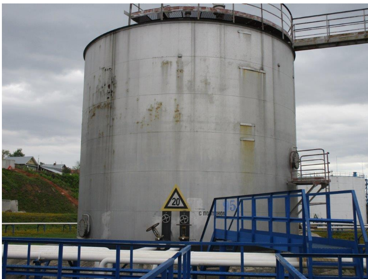
Рисунок 3 – Общий вид резервуара вертикального стального цилиндрического РВСП-700
