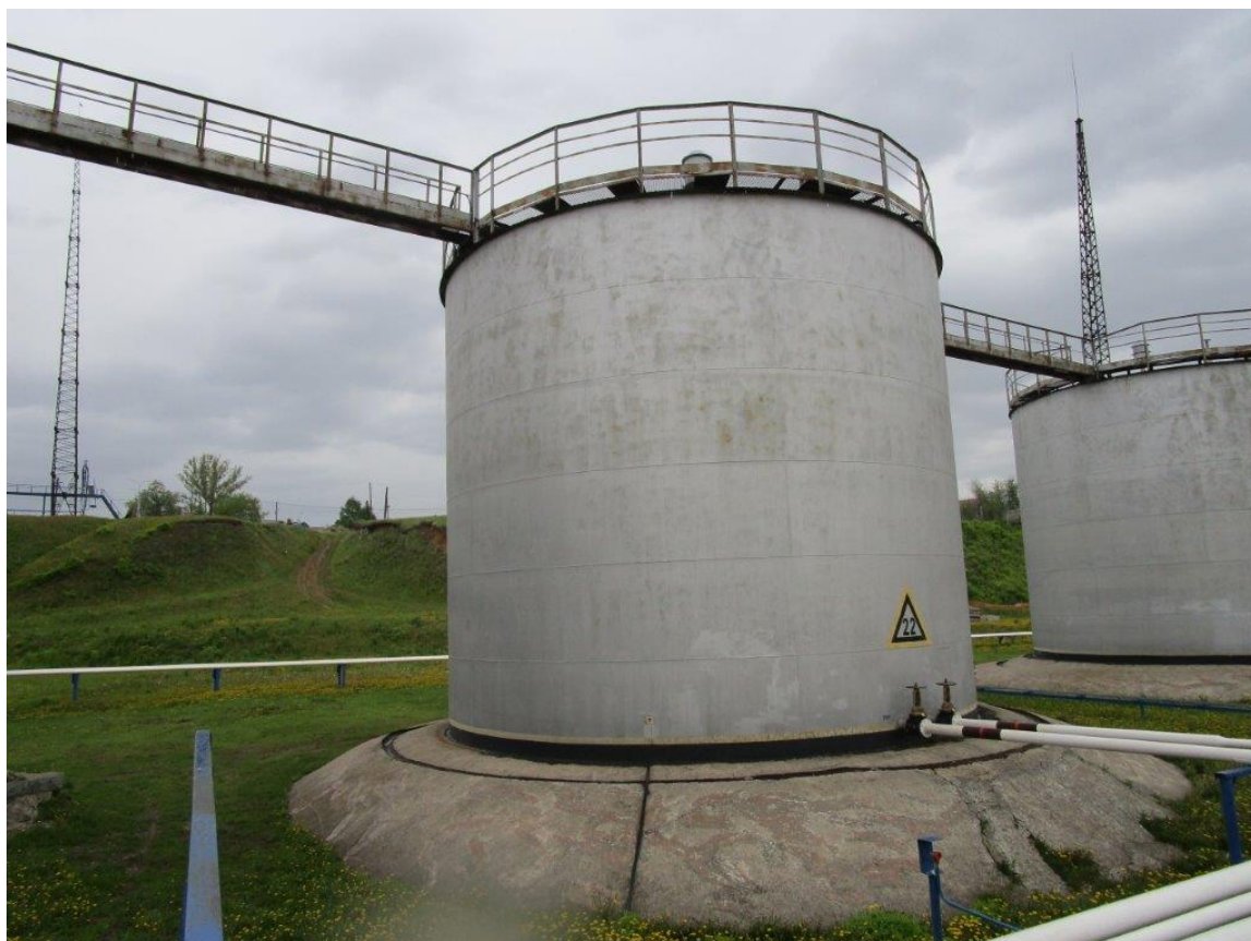
Рисунок 2 – Общий вид резервуара вертикального стального цилиндрического РВС-700
