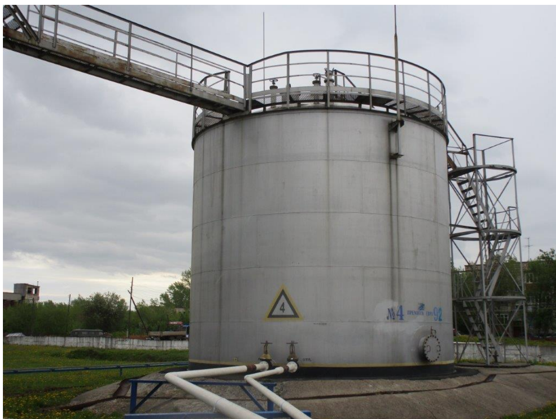
Рисунок 1 – Общий вид резервуара вертикального стального цилиндрического РВС-400
