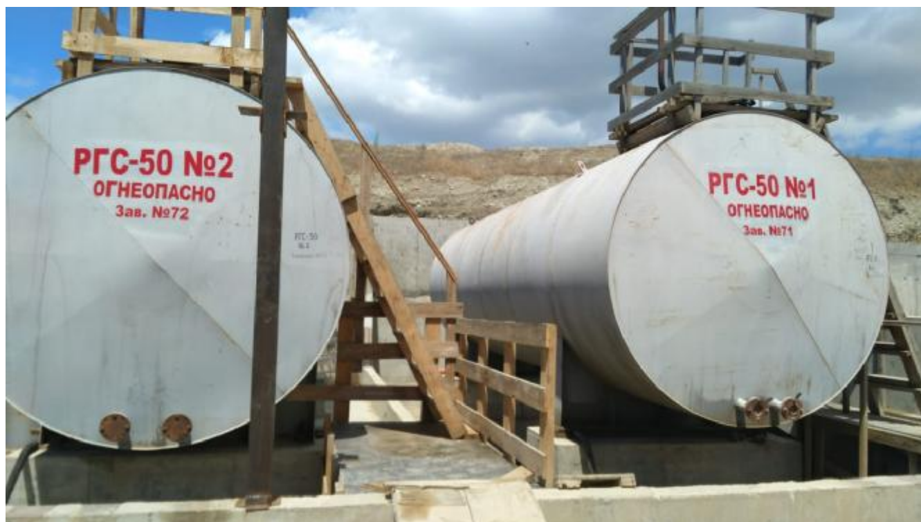
Рисунок 1 - Общий вид резервуаров
