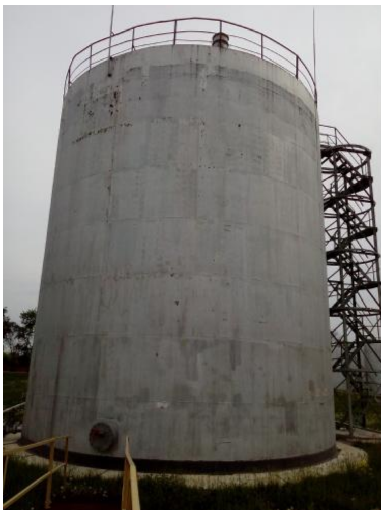
Рисунок 1 - Общий вид резервуара стального вертикального цилиндрического РВС-1000
