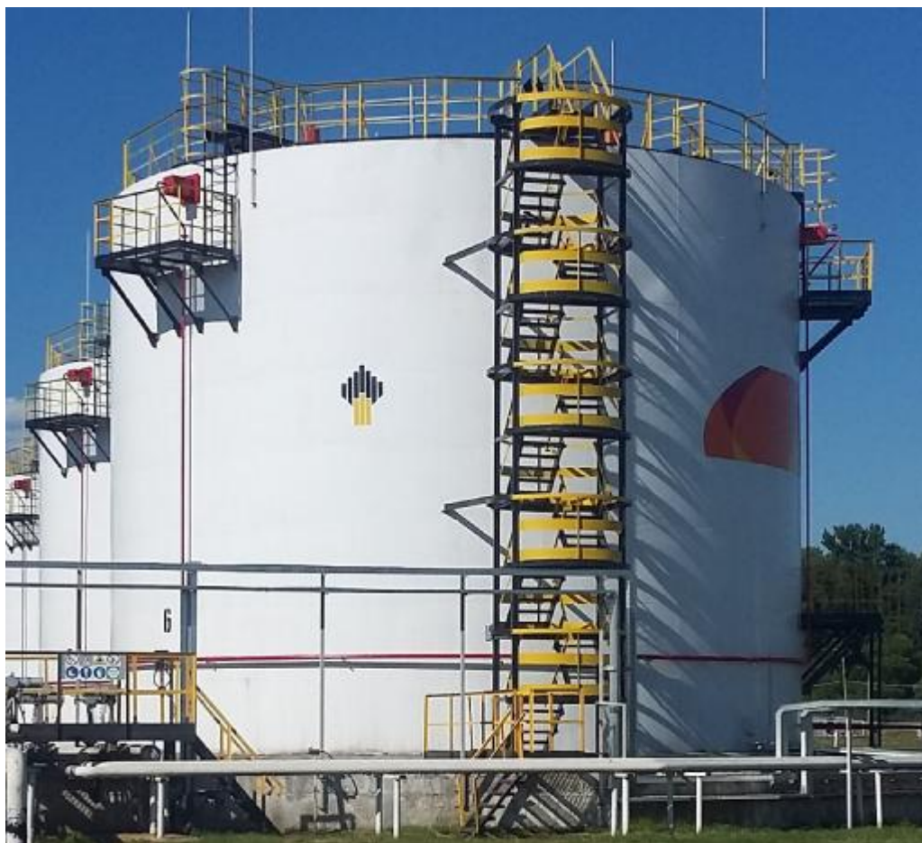
Рисунок 2 - Общий вид резервуара стального вертикального цилиндрического РВС-2000
