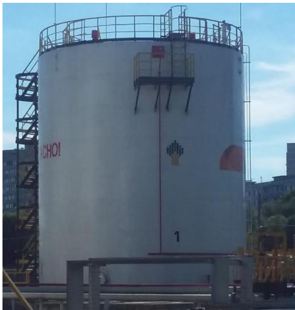
Рисунок 1 - Общий вид резервуара стального вертикального цилиндрического РВС-1000
