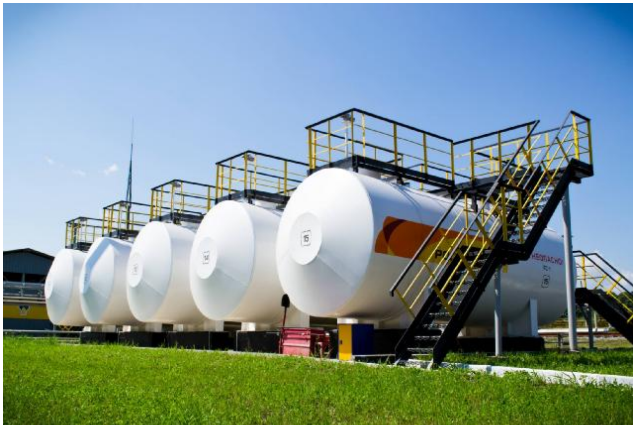
Рисунок 1 - Общий вид резервуара стального горизонтального цилиндрического РГС-75
