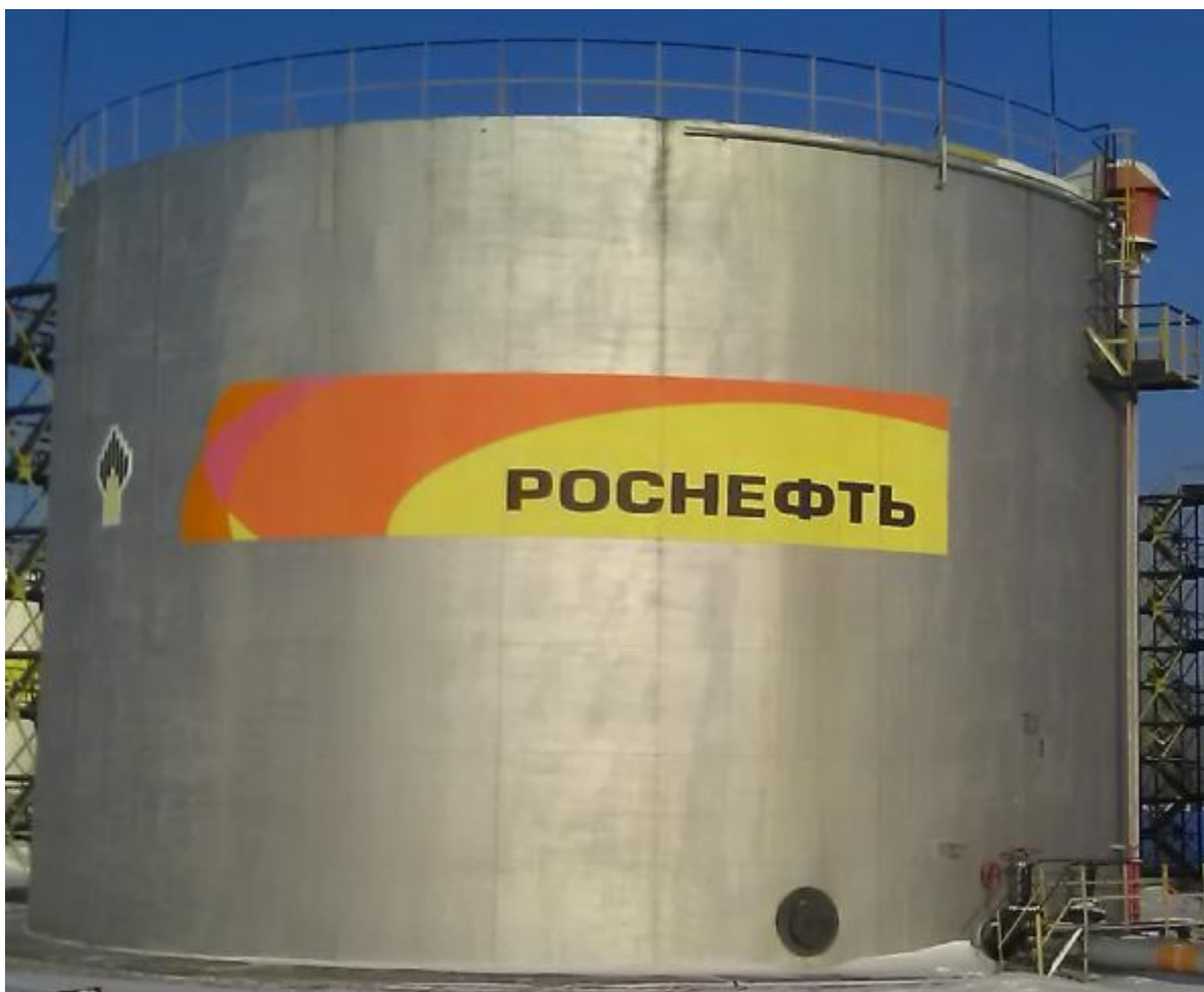
Рисунок 1 - Общий вид резервуара стального вертикального цилиндрического РВС-3000
