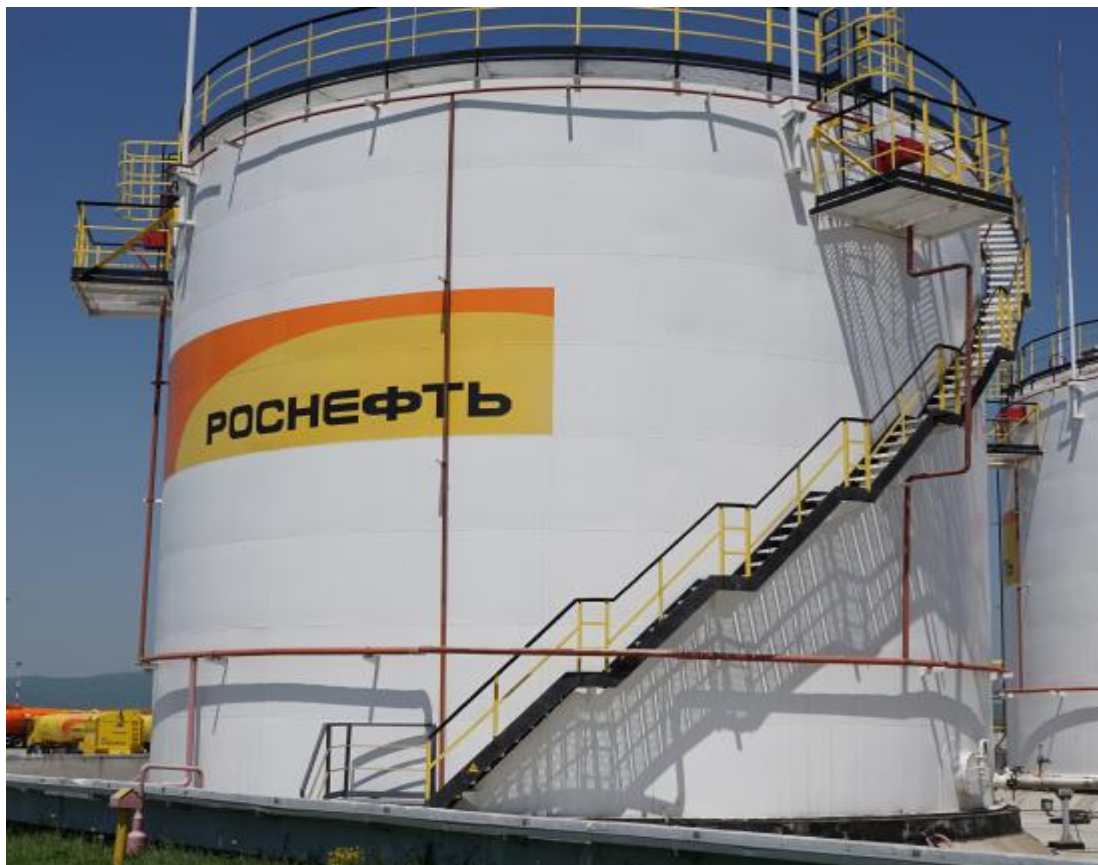
Рисунок 1 - Общий вид резервуара стального вертикального цилиндрического РВС-2000
