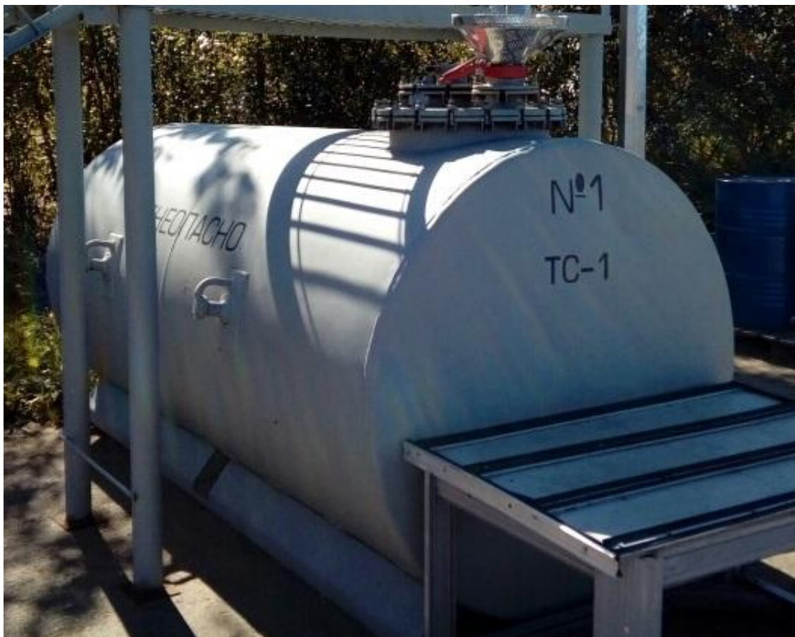
Рисунок 1 - Общий вид резервуара стального горизонтального цилиндрического РГС-4
