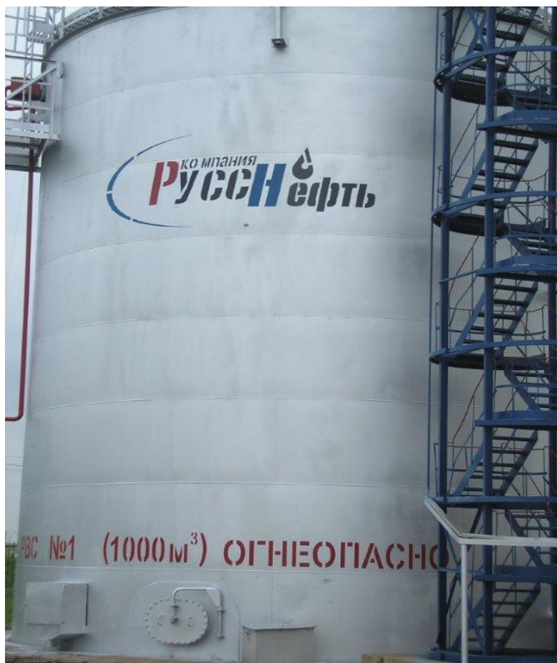
Рисунок 1 - Резервуар вертикальный стальной РВС-1000
