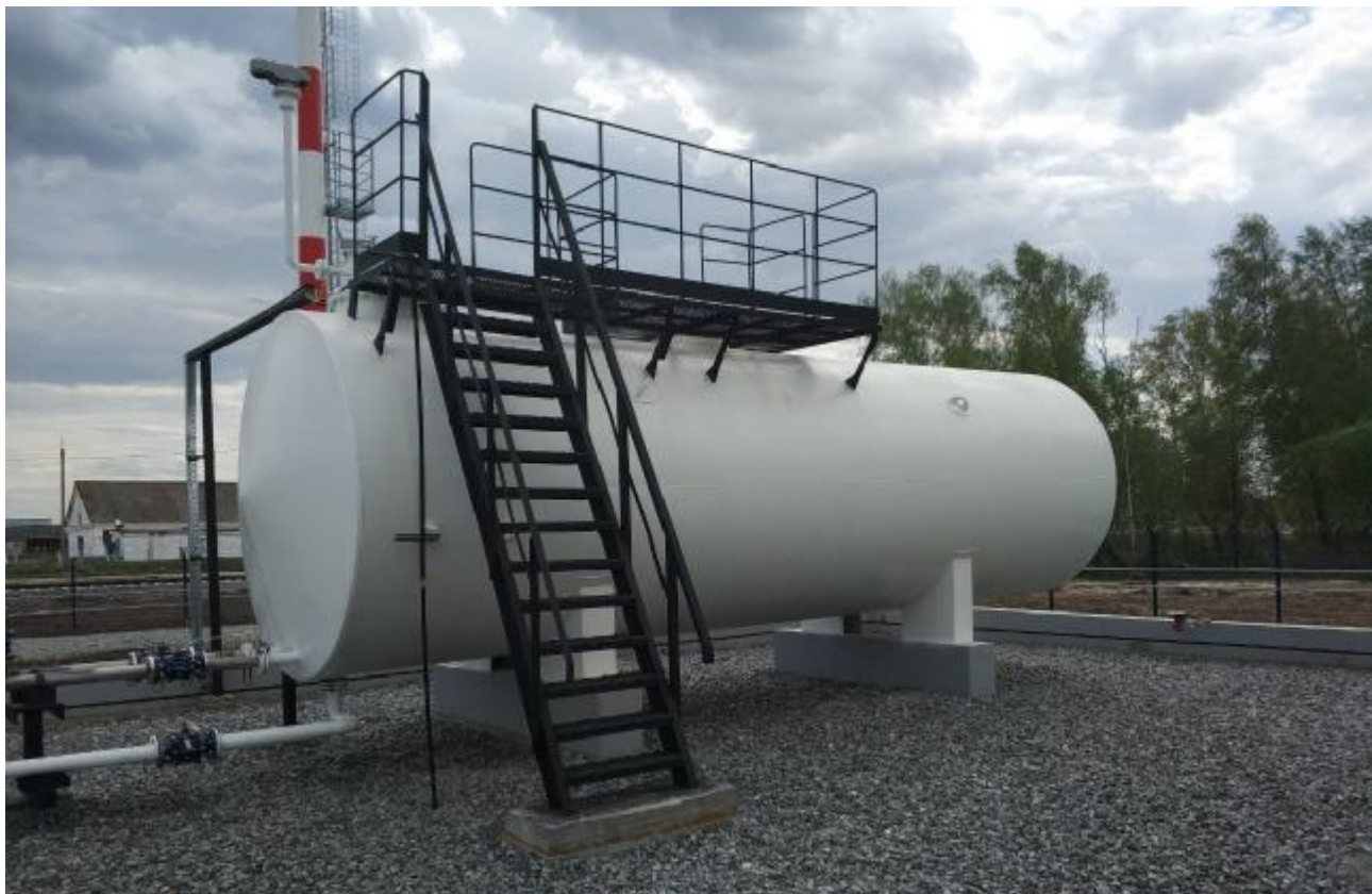
Рисунок 1 – Общий вид резервуара РГС-50
