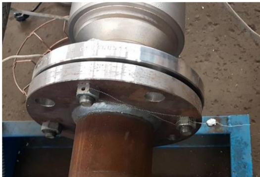
Рисунок 3 - Пломба поверителя, препятствующая демонтажу счетчика
