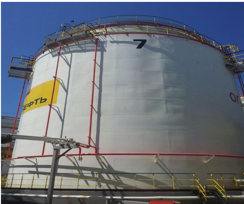
Рисунок 1 - Общий вид резервуаров с защитной стенкой РВСП-3000
