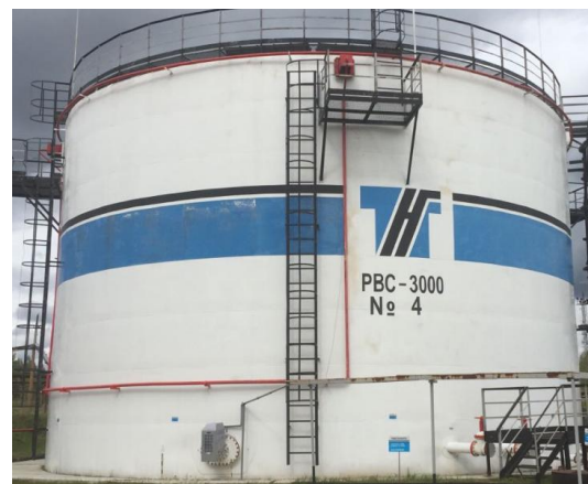
Рисунок 2 - Общий вид резервуара РВС-3000 № 4
