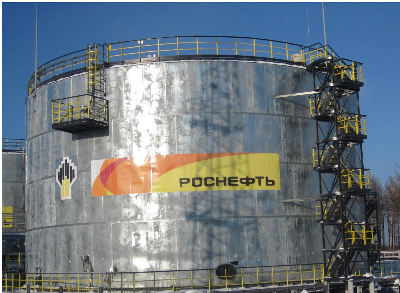
Рисунок 1 - Общий вид резервуара стального вертикального цилиндрического РВС-5000
