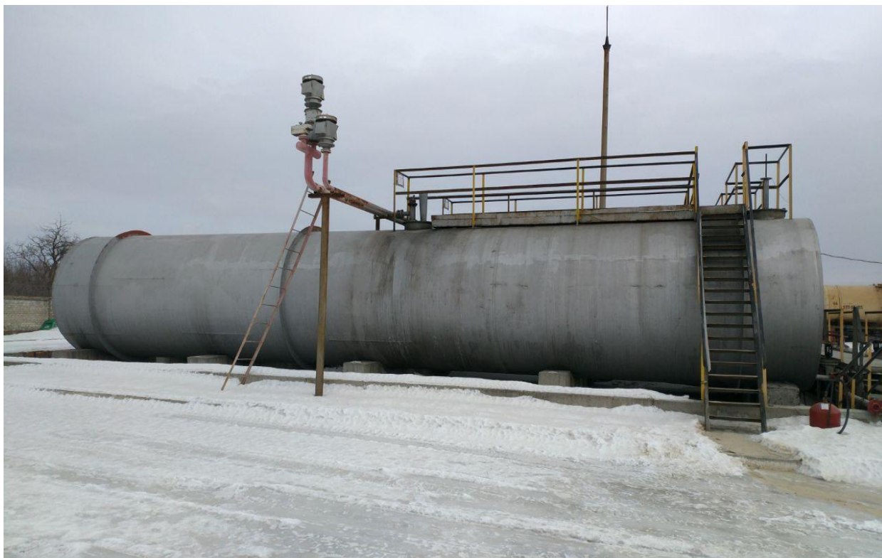
Рисунок 1 - Общий вид резервуара стального горизонтального цилиндрического РГС-150
