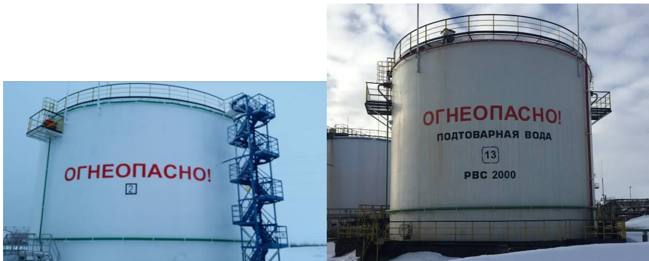
Рисунок 1 - Общий вид резервуаров РВС-2000 № 13, РВС-5000 № РОС-2(2)
