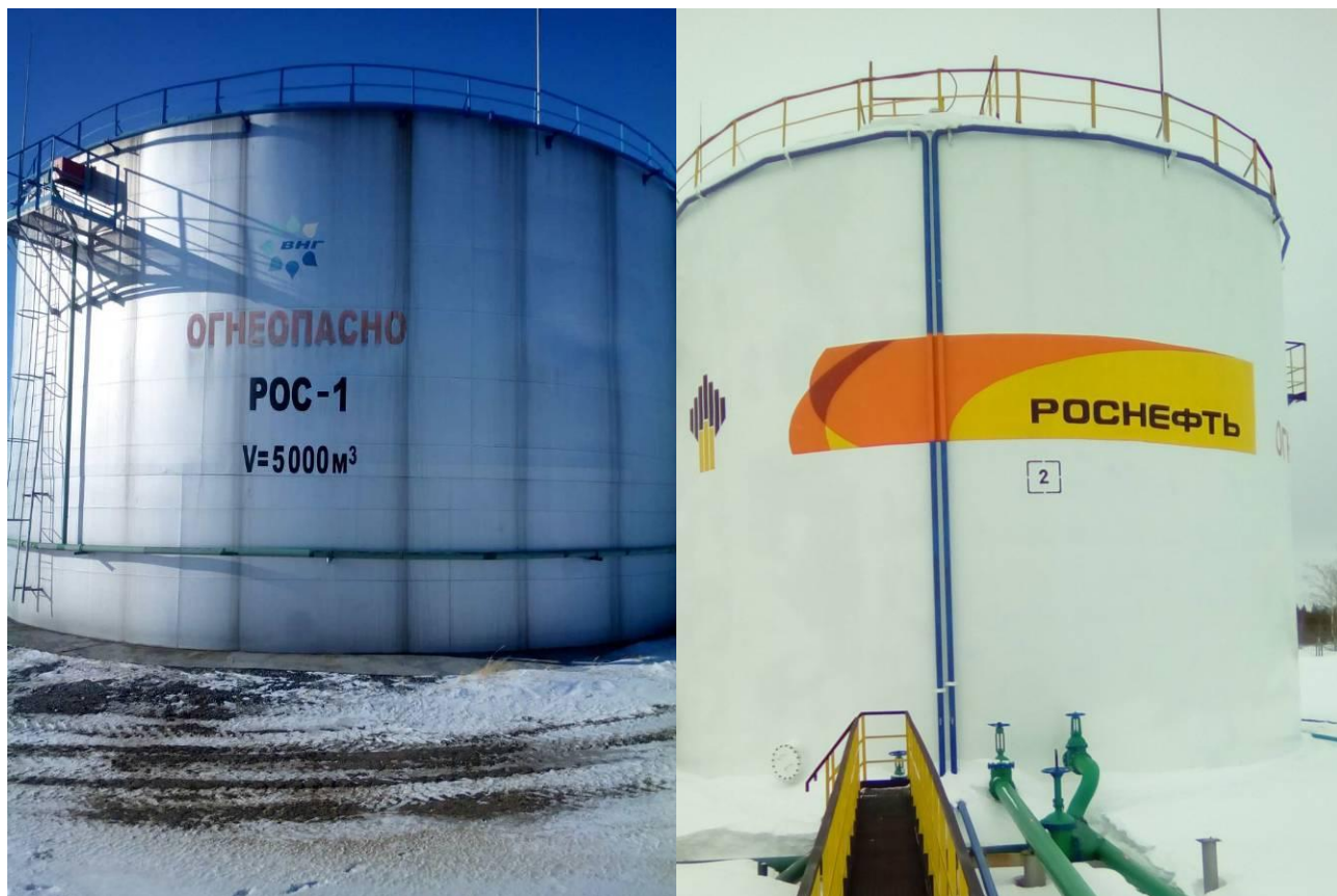
Рисунок 1 - Общий вид резервуаров РВС-2000 № РОС-2(2) и РВС-5000 № РОС-1(1)
