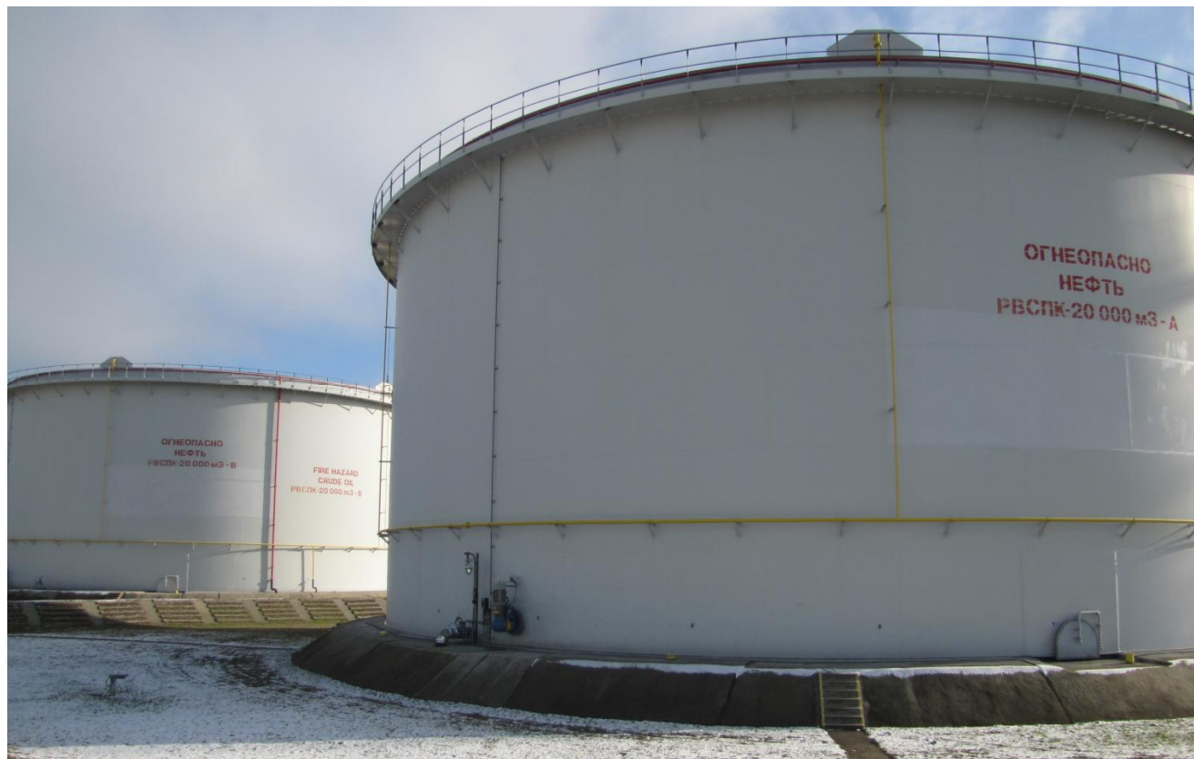
Рисунок 1 - Общий вид резервуаров РВСПК-20000
