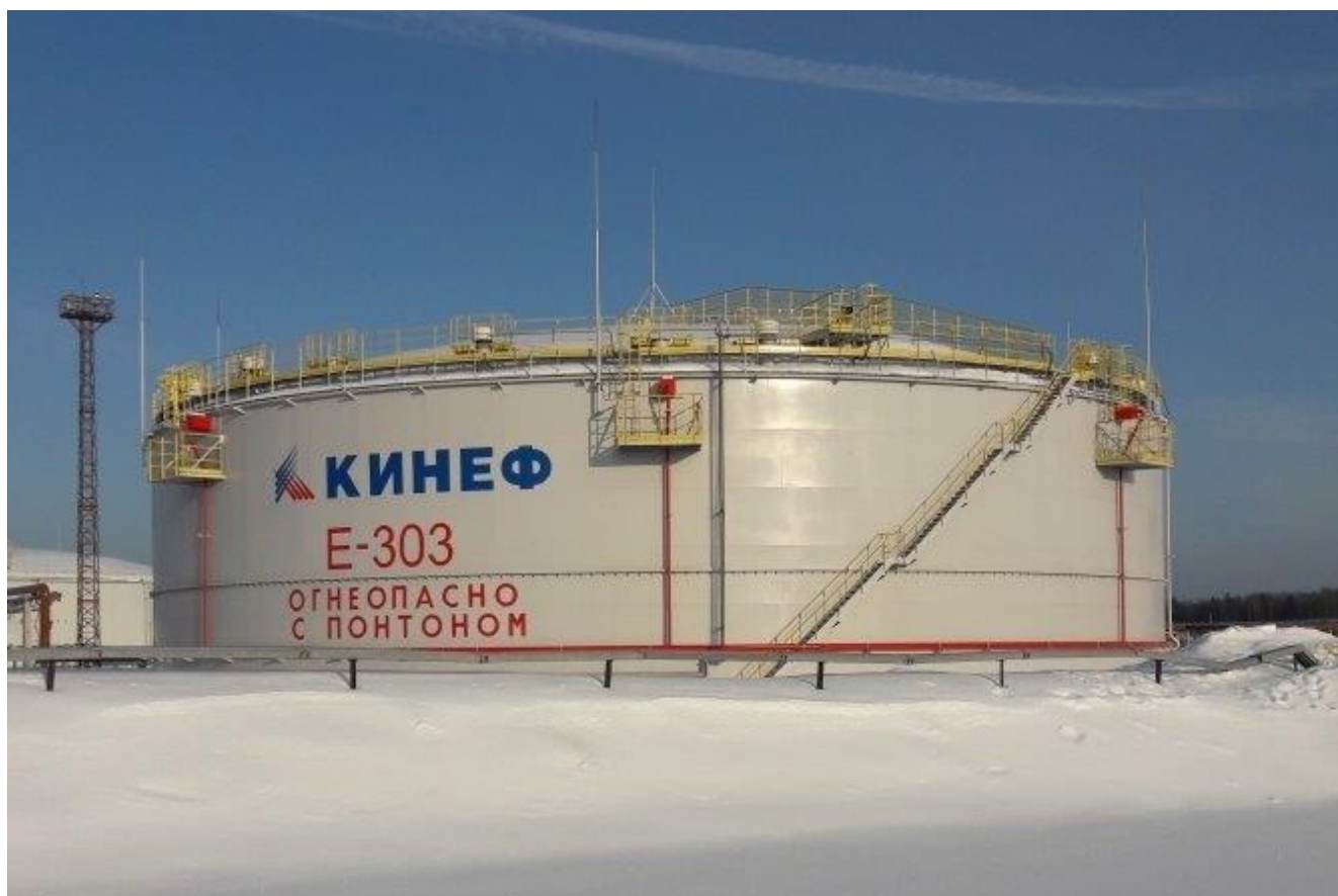
Рисунок 2 - Общий вид резервуара РВСП-20000
