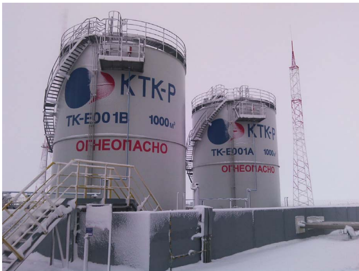
Рисунок 1 - Общий вид резервуара РВС-1000
