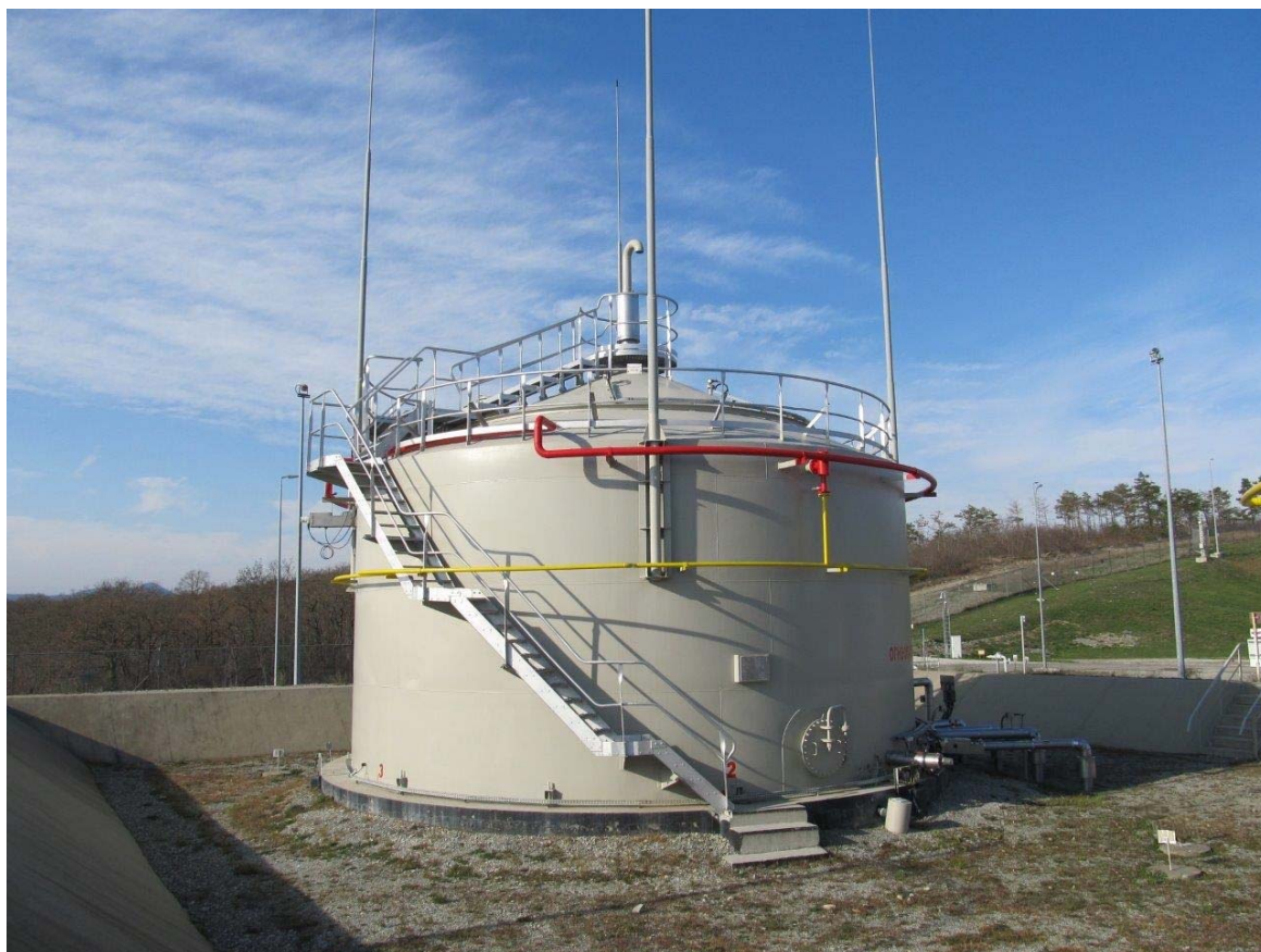
Рисунок 1 - Общий вид резервуара РВС-400
