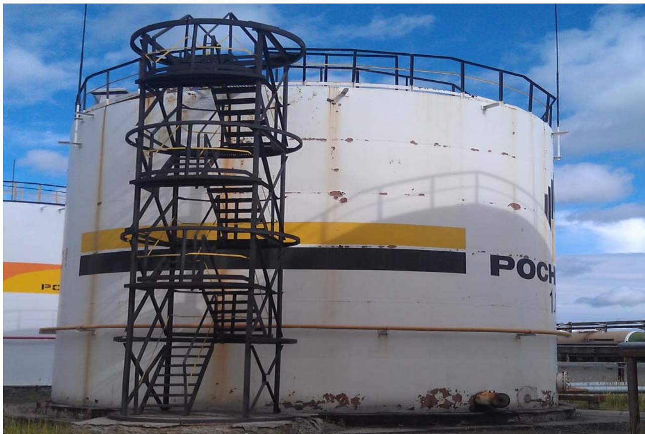
Рисунок 4 - Общий вид резервуара стального вертикального цилиндрического РВС-700
