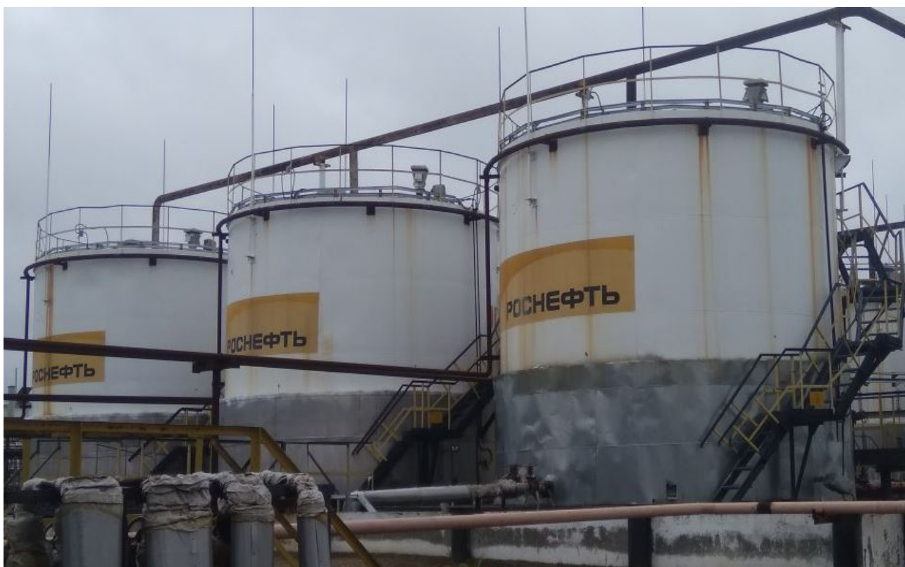
Рисунок 5 - Общий вид резервуара стального вертикального цилиндрического РВС-200
