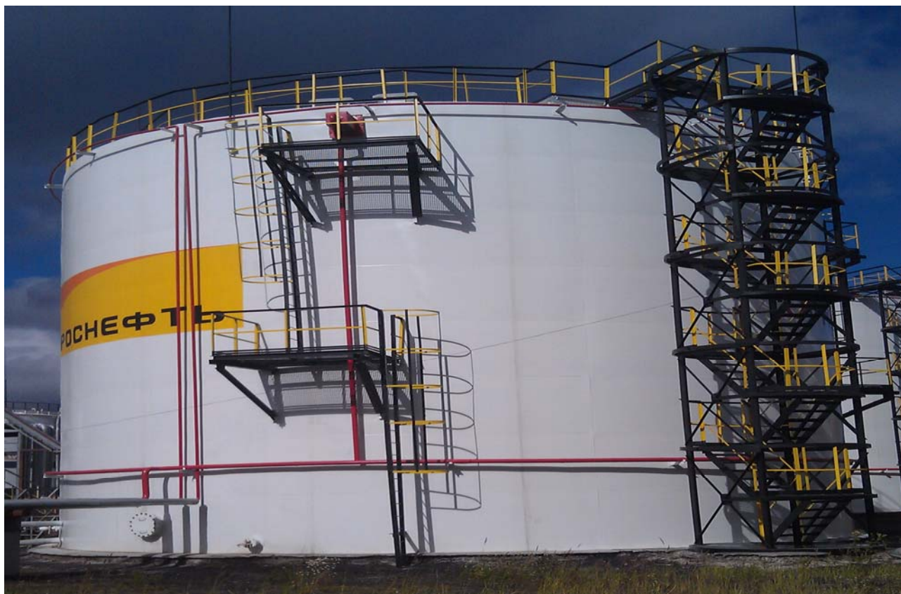
Рисунок 2 - Общий вид резервуара стального вертикального цилиндрического РВС-2000
