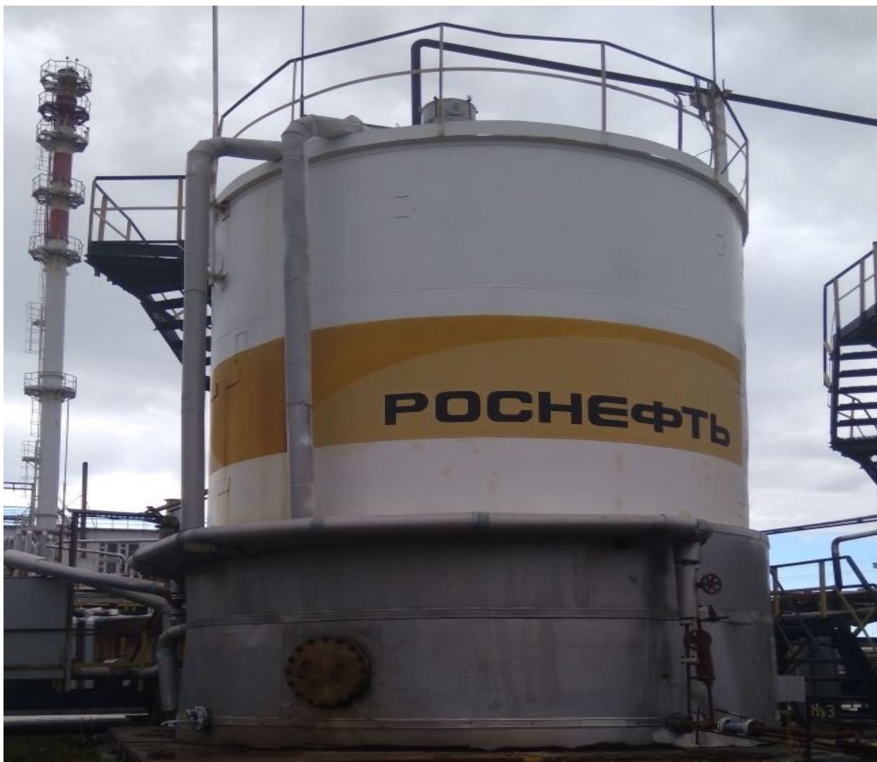
Рисунок 6- Общий вид резервуара стального вертикального цилиндрического РВС-100
