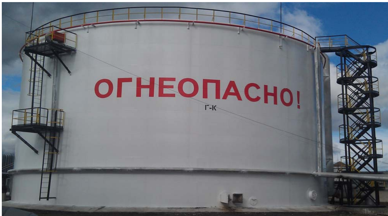
Рисунок 1 - Общий вид резервуара стального вертикального цилиндрического РВС-5000
