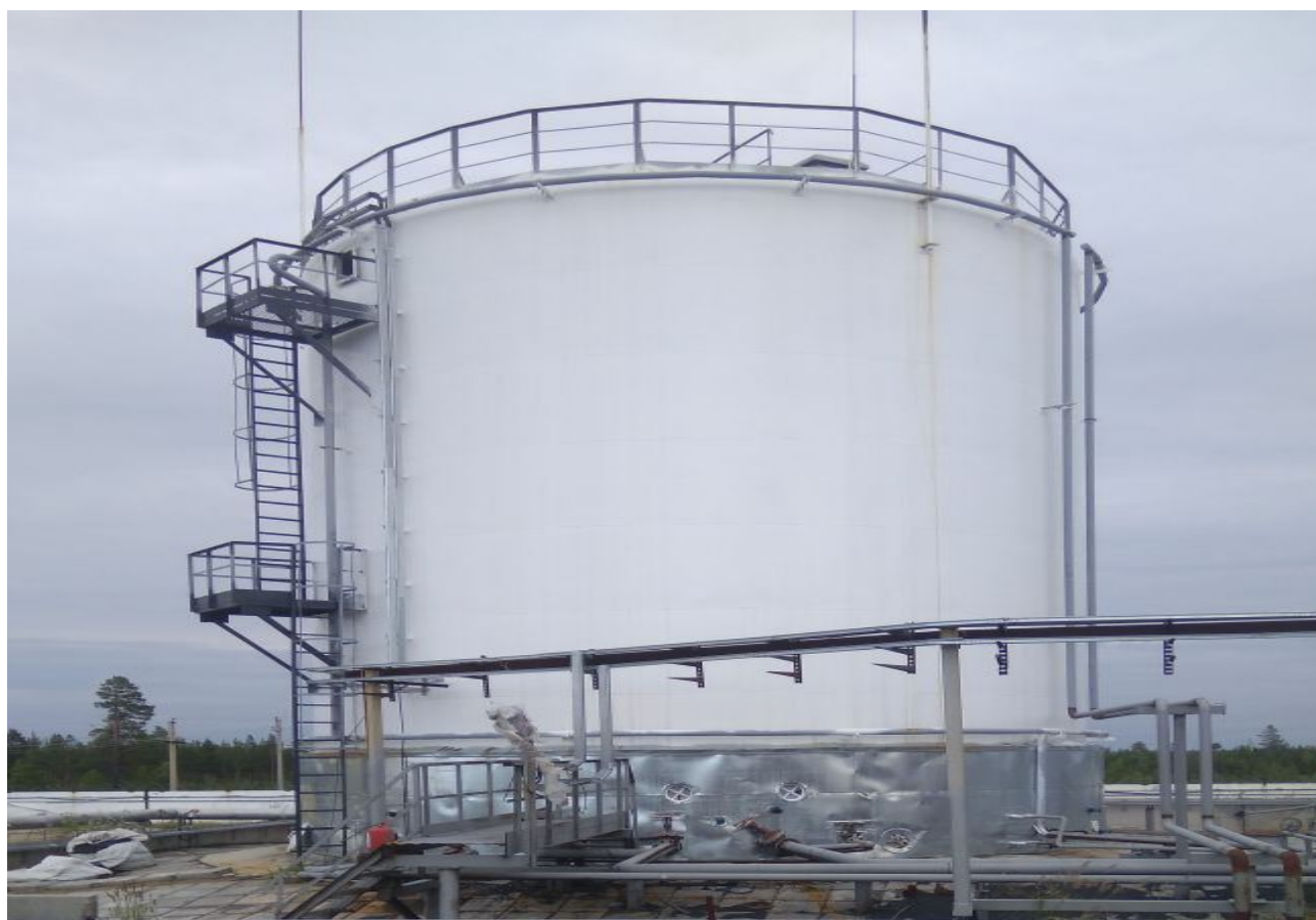
Рисунок 3 - Общий вид резервуара стального вертикального цилиндрического РВС-1000
